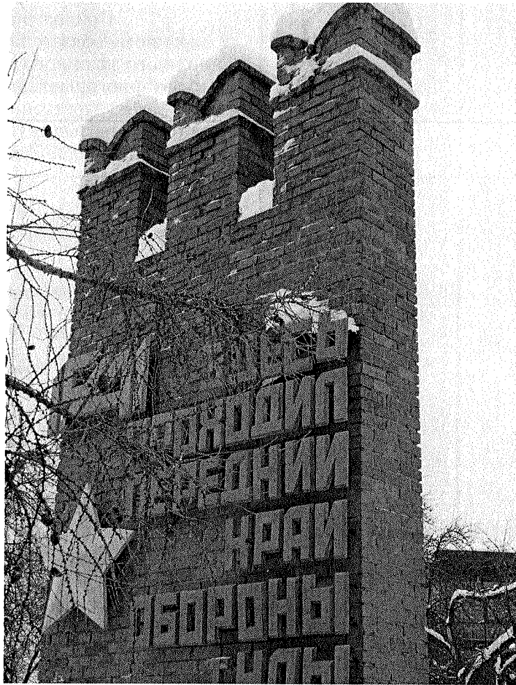
Фото 4. Фрагмент кирпичной стены.
