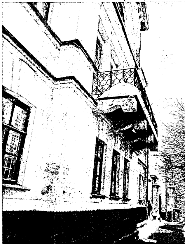
Фото 7. Фрагмент главного западного фасада.
