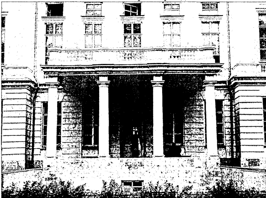
Фото 5. Фрагмент восточного фасада
