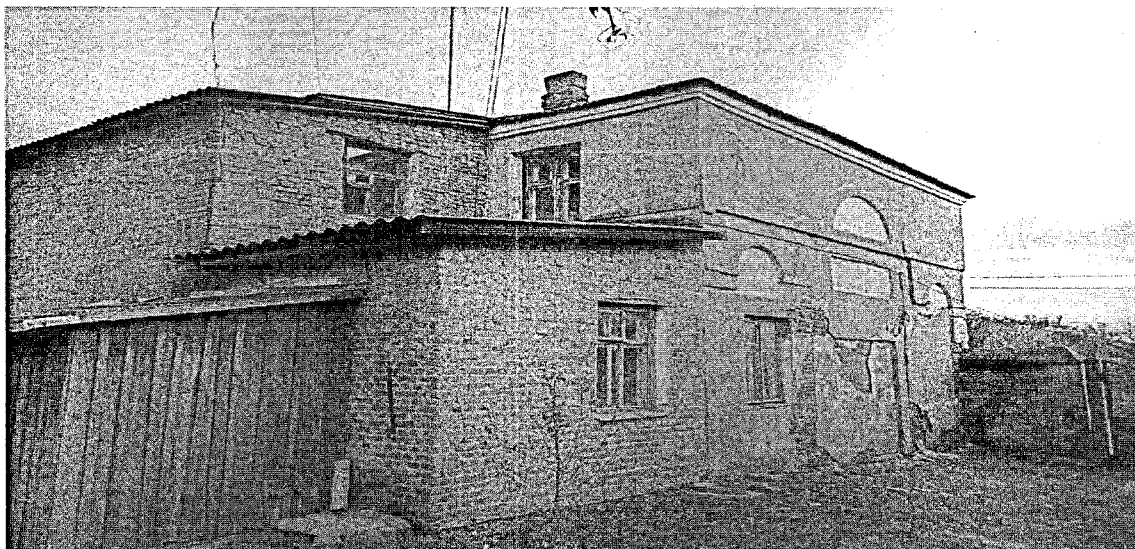
Фото 3. Северо-западный фасад д. 51 лит. А.
