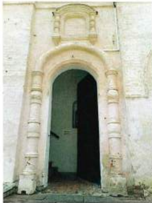
Вид 1. Портал входного проёма на лестницу
