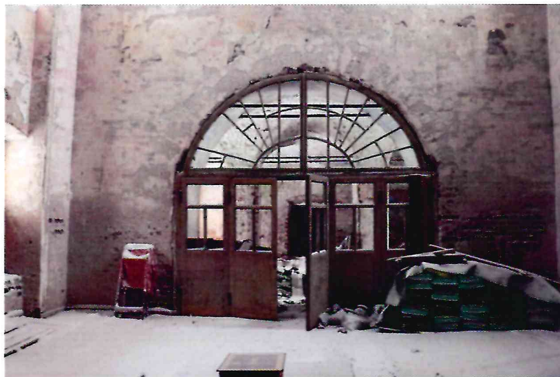
Фото 1. Историческое столярное заполнение арочного дверного проема из трапезной в четверик
