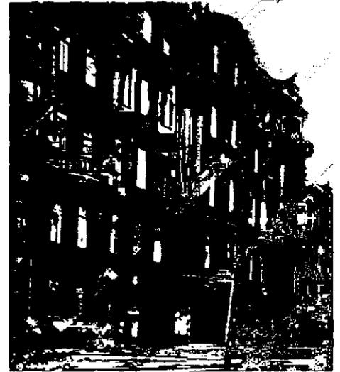
раскрепованные профилированные междуэтажные тяги в уровне второго - третьего и четвертого - пятого этажей;
