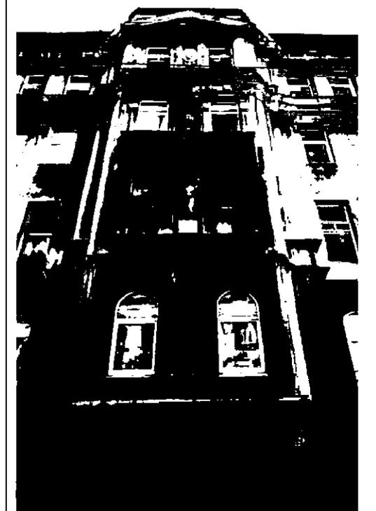
дугообразные в плане балконы в уровне третьего этажа по 1-2ой и 11-12ой световым осям, с ограждением в виде лепной балюстрады под профилированным поручнем;
