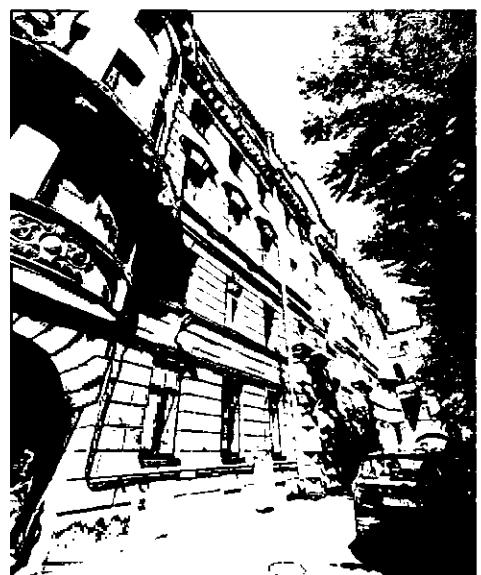
два эркера завершенные балконами (над воротным проездом и 12-й световой оси) – местоположение (на уровне 2-4-го этажей, балконы в уровне 3-го этажа (ограждение утрачено), конфигурация (полуциркульные в плане), габариты;
