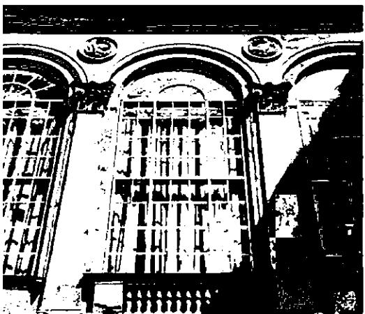
два эркера с двумя лоджиями по бокам завершенные балконами – местоположение (на три световые оси, в уровне 4-го этажа), конфигурация (прямоугольный в плане с центральным трехгранным выступающим объемом), габариты;
