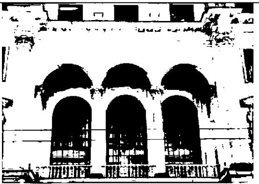
воротный проезд – трехчастный на восьми круглых колоннах и восьми полуколоннах, муфтированные (материал – мрамор, фактура обработки камня), перекрытый крестовыми сводами на подпружных арках, образующие кессонированный потолок;
