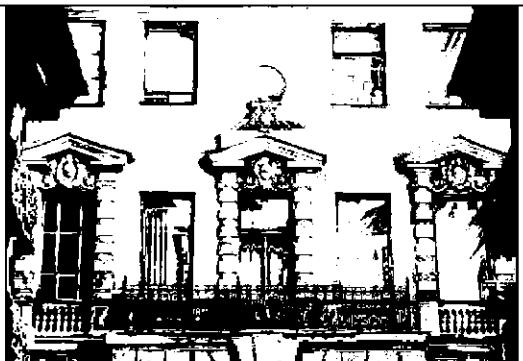
оформление полуциркульных оконных проемов – плоские пилasters в междуоконном пространстве с композитными капителями, архивольт, пояс с профилем; над оконным пространством две круглые филенки с орнаментом из шлема и венка лавра; под оконными проемами ложная балюстрада с фигурными балясинами и прямоугольными тумбами;
