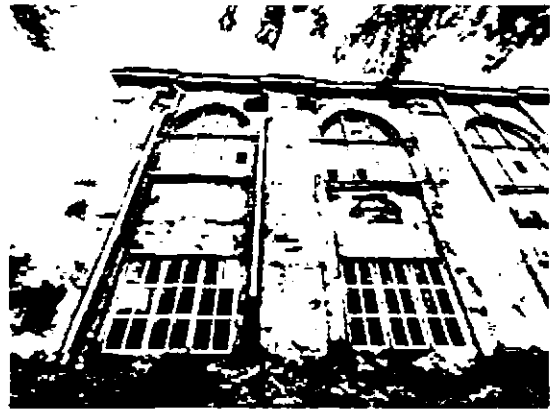
лицевой фасад по Октябрьской набережной
