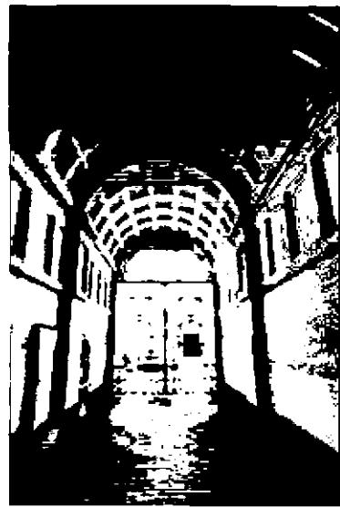
материал и характер обработки фасадной поверхности: гранитные плиты и терразитовая штукатурка – фасада, известняковые плиты, облицовочная плитка и гладкая штукатурка – воротного проезда;
