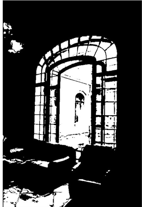
заполнение проема – рама двойная металлическая; в средней части крупный переплет с коробовым завершением и скругленными углами; по периметру – мелкая геометрическая расстекловка; центральная часть фланкирована каннелированными пилястрами с капителями, декорированными листом аканта;
