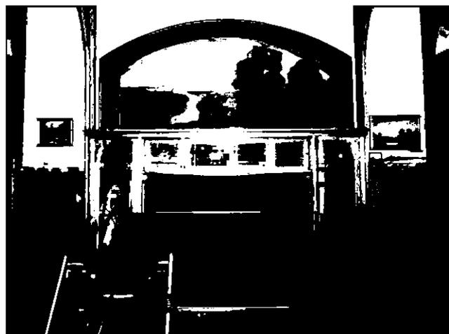
полки с четырьмя застекленными сдвижными створками; под нижней обвязкой – широкая балка с профилем, между ней и стеной – обтянутый тканью свод в четверть окружности;
