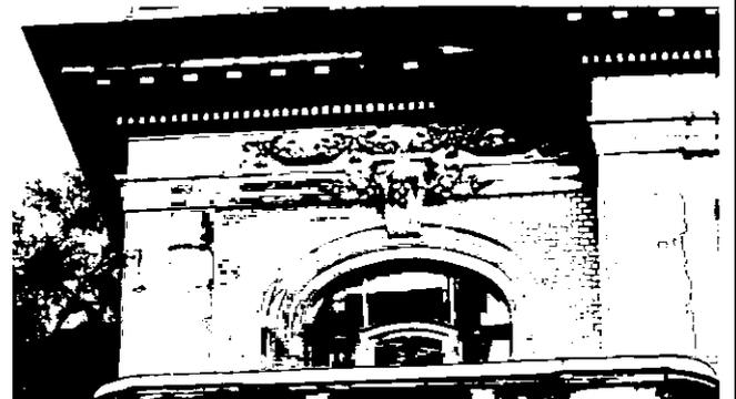
профилированные междуэтажные тяги и подоконные карнизы, включая тягу с модульонами – в уровне между 1-2-м этажами; широкий гладкий фриз; профилированный венчающий раскрепованный карниз на кронштейнах, с порезкой дентикулами;
