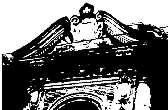
разорванный фигурный фронтон – местоположение (в завершении южной раскреповки). габариты, конфигурация: в тимпане фронтона горельефная композиция из медальона в картуше, фланкированного листьями аканта;
