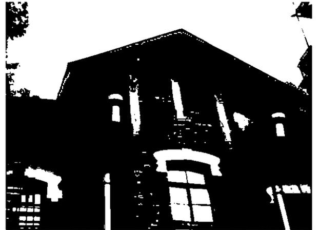
треугольный шипец с деревянными фигурными консолями – в центральной части восточного фасада;
