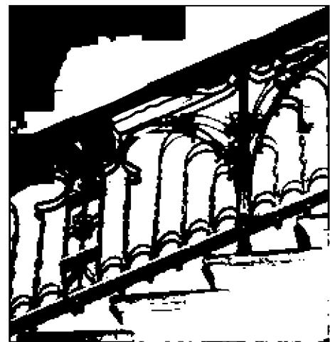
межэтажная трехмаршевая лестница 2ЛК и межэтажная двухмаршевая с поворотом лестница 3 ЛК со ступенями известняковой плиты по металлическим косоурам и перильным ограждением из прямоугольных в сечении перекрученных прутьев с горизонтальными направляющими;
