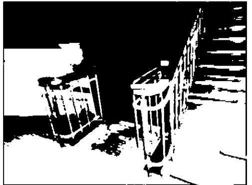
металлическое ковано-литое ограждение лестницы выполнено в виде круглых в сечении вертикальных стоек, завершенных «шишечками», перехваченных горизонтальными, прямоугольными в сечении планками;
