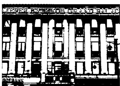
оконные проемы третьего и дверные балконные проемы четвертого этажей по крайним восточной и западной осям вписаны в ниши с лучковым завершением. объединены уплощенным наличником с замковым камнем над проемом третьего этажа и рельефной композицией с шарами и гирляндами на каннелированных кронштейнах с гуттами - над проемами четвертого этажа;
