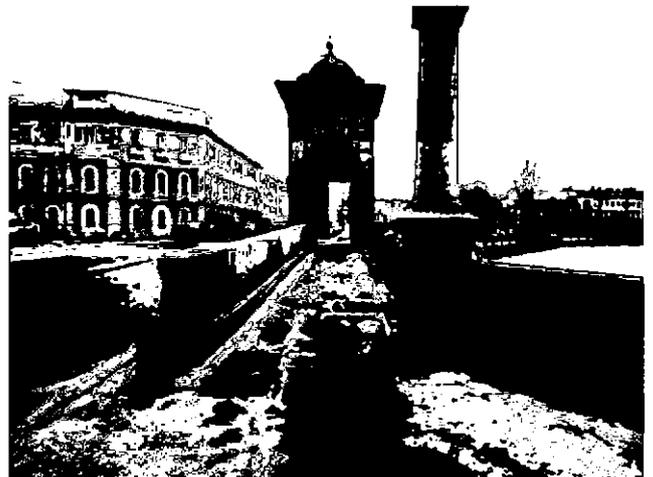
пешеходная зона отделена от проезжей части глухим парапетным ограждением с фигурным завершением в торцевых частях;
