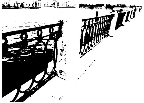
парапетные вертикальные тумбы с профилированным плинтусом и завершением в виде усеченной трапеции (розовый оvoidальный гранит рапакиви – от восточного берегового устоя Тучкова моста до западного берегового устоя Биржевого моста) с металлическими ажурными решетками между ними – кованые металлические звенья в виде пересекающихся овальных элементов, с фризом из колец по верхнему поясу;
