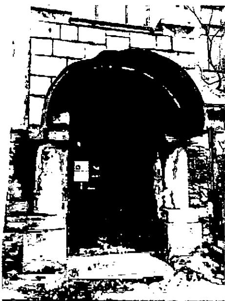
оформление воротного проезда – гранитный архивольт с замковым камнем;
