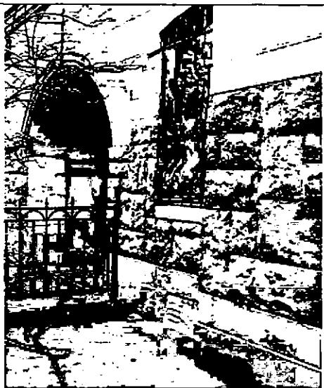
оформление портала парадного входа – гранитные трехчетвертные колонны на плинтах и кубическом основании, с полуциркульным архивольтом и аттиком, сложенным из квадров камня;
