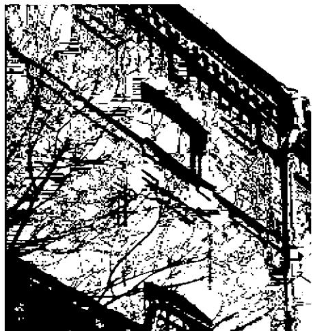
межэтажный карниз в виде фигурной кладки: 2 ряда поребрика (между 1 и 2 этажами южной части восточного фасада);
