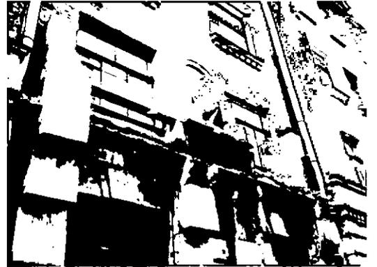
торцевой северо-восточный фасад – горизонтальные членения – пояс с «сухариками»; карниз с модульонами на оконных проемах четвертого этажа;
