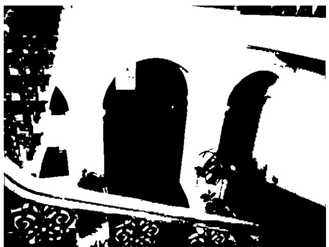
лестницу восточного флигеля – двухмаршевую, с известняковыми ступенями, с металлическим ограждением простого рисунка из вертикальных прутьев, с профилированным деревянным поручнем.
