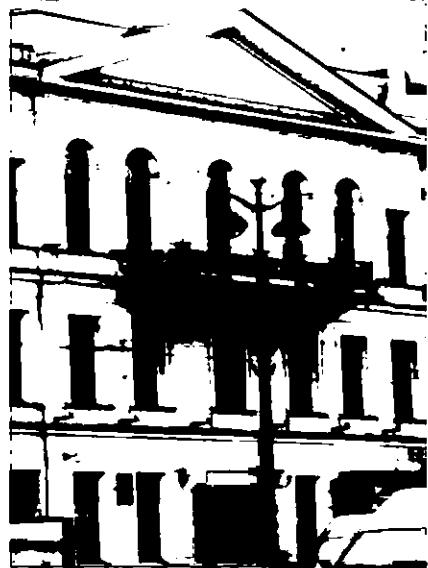
балкон в уровне 3-го этажа центральной части фасада, в три световые оси, на шести металлических кронштейнах, с литым ограждением; рисунок кронштейнов и ограждения (шишки, растительные завитки. фигурные каннелированные стойки на четырех львиных лапах каждая, секции растительного рисунка. пояса меандра);
