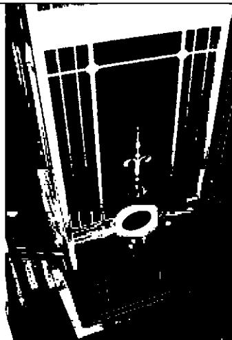
кабина лифта с обшивкой красным деревом: с двух сторон кабины – раздвижные дверцы с остекленными верхними филенками (стекло с фацетом); на боковой стенке вмонтировано зеркало с фацетом: с внутренней стороны дверей – латунные ручки-скобы;
