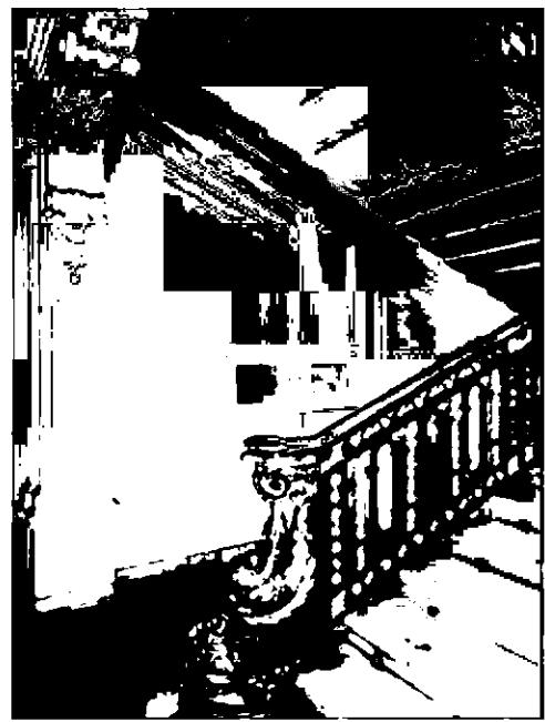
лестницу корпуса по Английской наб. (2-ЛК) – выполненную по проекту А.А. Степанова в 1882 г. – дубовую, резную, двухмаршевую, на дубовых косоурах и опорных столбиках, с наборными деревянными ступенями, с дубовым ограждением из секций, разделенных столбиками; секции состоят из: балюсина и полубалюсина (у столбиков), соединены арочками: над и под балюсинами, на столбиках резные накладные цветочные гирлянды, филенки фигурные и с бриллиантовым рустом, с профилированным дубовым поручнем;
