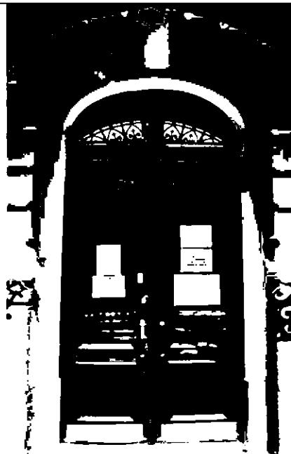
полуциркульный козырек на кованых кронштейнах, его местоположение, конструкция, габариты, оформление (волютообразные завитки и кольца кронштейнов, кованый пояс растительного-геометрического орнамента);
