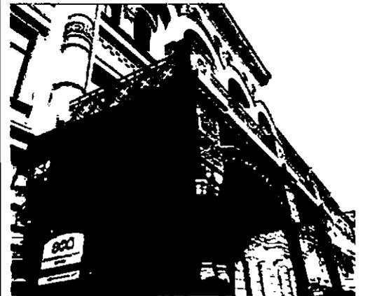
ограждение (сохранилось частично) в виде ажурных решеток геометрического рисунка (квадрифолий), установленных между прямоугольными в плане тумбами;
