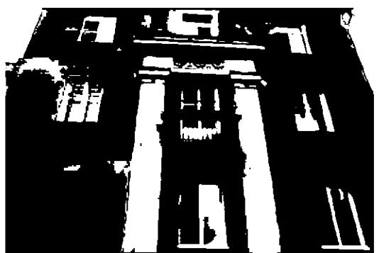
два стилизованных портика трехэтажного корпуса – местоположение (центральная часть восточного и западного фасадов), конфигурация (прямоугольные в плане), габариты, оформление – восемь пилястр, поддерживающих антаблемент, завершенный прямоугольным в плане балконом с кирпичными оштукатуренными опорными тумбами и металлической решеткой ограждения простого рисунка;
