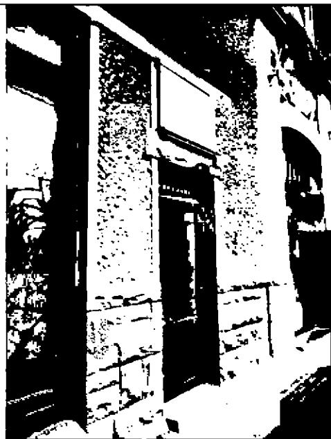
дверной проем лестницы З-ЛК (по центральной оси фасада по переулку) – конфигурация (с лучковым завершением), оформление (рамочный наличник);
