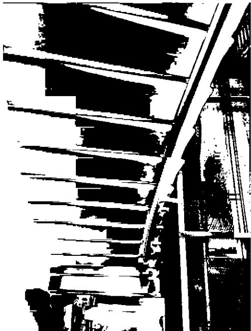
ограждение лестничных маршей черного металла, (ковка, прокат, слесарная сборка), рисунок в виде овалов соединенных малоформатными шарами; орнамент в виде «геометрических встречных волют» в местах сопряжений звеньев;
