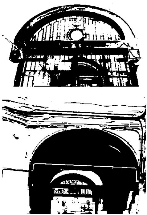
ажурные чугунные кронштейны козырьков с рисунком растительного характера из листьев аканта, шестилепестковых и «вихревых» розеток, с водосточными трубами круглого сечения, литые;\*
