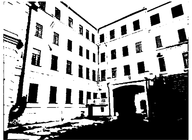
Вид на корпус 1, литера Б (северный и восточный дворовый фасад) и корпус 2, литера Б (восточный фасад)
