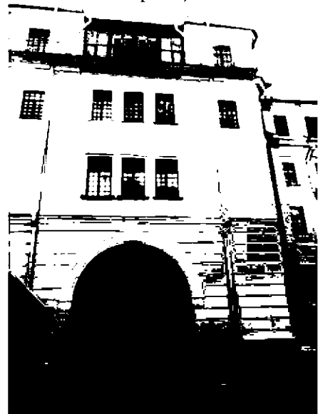
корпус 1, литера Б (северный дворовый фасад)
