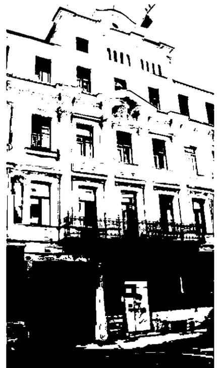
по две каннелированные полупилястры композитного ордера в крайних осях фасада, в уровне 2-3-го этажей;
