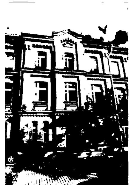
перемычки ниш в уровне третьего этажа - кладка выпущенного кирпича в виде стилизованных машикуль;
