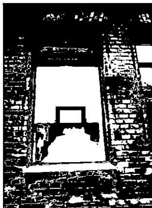
широкие оконные проемы 2 этажа (по 1-8, 12-19 оси) – местоположение, габариты, конфигурация (прямоугольные), в прямоугольных нишах, с клинчатыми перемычками, профилированными наличниками из лекального кирпича, с прямоугольными нишами в подоконном пространстве, декорированными полихромной керамической плиткой геометрического рисунка;
