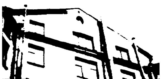
манкардный этаж с выступающими объемами окон с металлическимкрытием и металлическим ограждением простого рисунка над венчающим карнизов;
