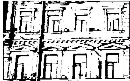
балкон на 4-х парах гранитных кронштейнов - местоположение (в 10-13-й световых осях в уровне 2-го этажа фасада по Невскому пр.), конфигурация (прямоугольный в плане), габариты:
