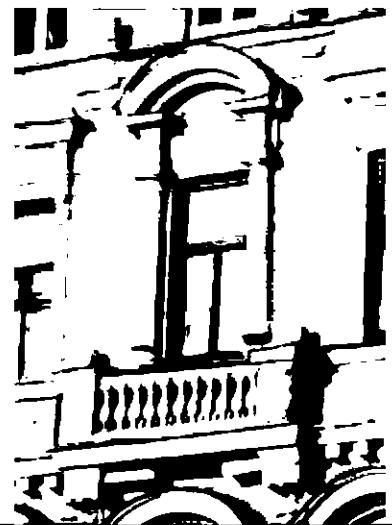
балкон – местоположение (в угловой части здания в уровне 3-го этажа фасада по Невскому пр.), конфигурация (полуциркульный в плане), габариты; ограждение балкона с балюсинами и тумбами (утрачено);
