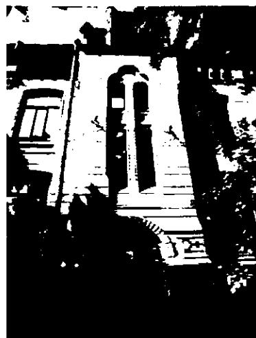
стилизованные машикули в завершении фасадов; венчающий профилированный карниз с зубчиками;
