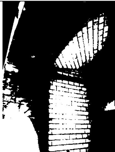
фигурные декоративные ниши на фасаде по 14-й линии, ниша с трехлопастным завершением с вписанными оконными проемами юго-восточной лестницы, портал входа в виде ниши со стрельчатым завершением и круглым окном-люкарной в тимпане, нишки малого формата (стилизованные бойницы) под венчающим карнизом;
