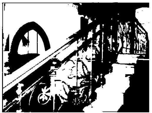
парадная лестница – местоположение, габариты, конструкция (ступени консольно закреплены в стене), тип (двухмаршевая), ступени (из лещадной плиты),
